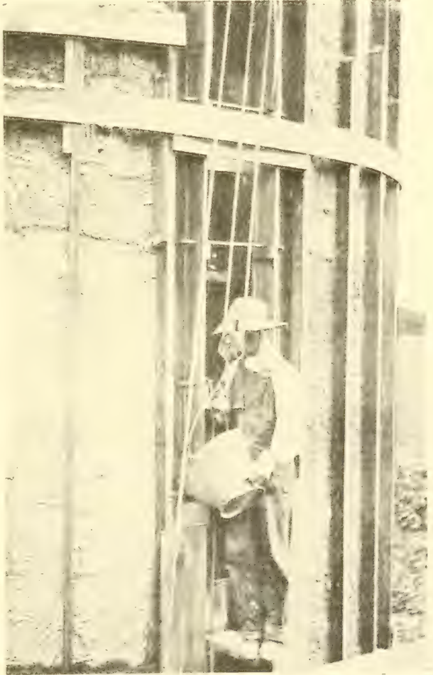
Pouring the Door Posts.
